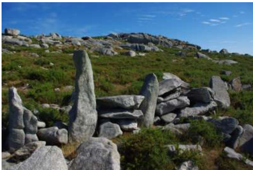
Base dun tramo de parede onde podemos ver a técnica construtiva empregada no foxo
